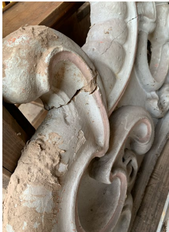
Abb. 5 Fragile, sich vom Untergrund lösende Malschicht auf einem Holzornament. Der tiefe Riss kennzeichnet eine instabile Leimverbindung im Holzträger.
