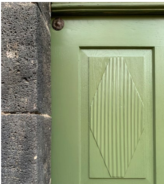
Abb. 6 Haustür von 1840 mit Leinölfarbanstrich.
